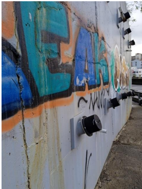
Fotografía nº2. Detalle del muro anclado actual
