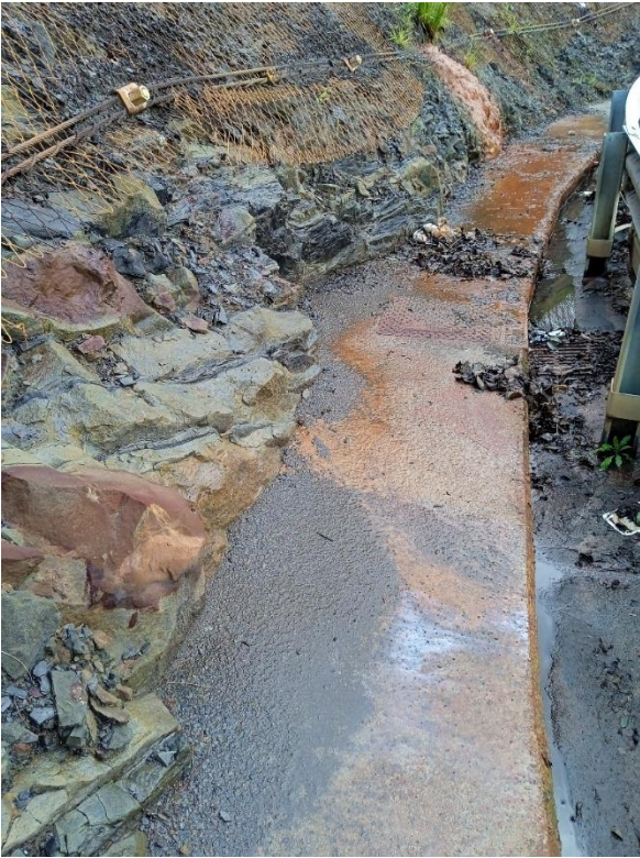
Fotografía nº1. Vista del macizo rocoso en la rotonda compuesto por una alternancia de limolitas y areniscas. Obsérvese además la malla de cable instalada
